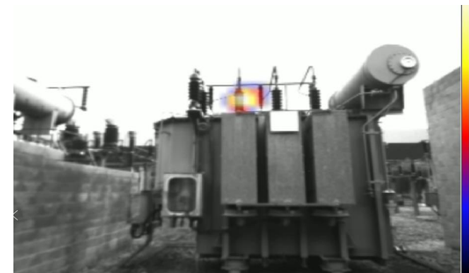
Imagem térmica de cabos eléctricos
